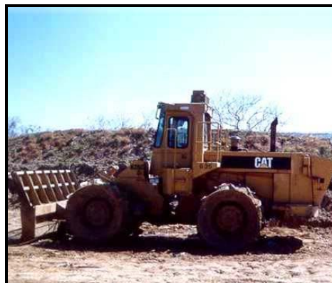
Figura 7- 3 Descarga, extensión y compactación de los residuos
